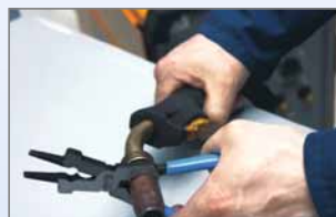
удаление и установка сопла
